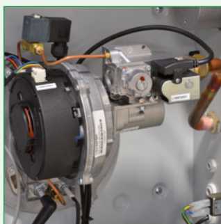
Vysoká energetická účinnost díky 2stupňovému plynovému hořáku
